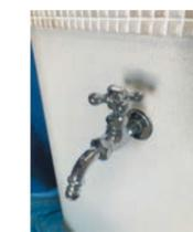
ユニオンシンクの側面に蛇口を取り付ける際に固定台座で固定します。
