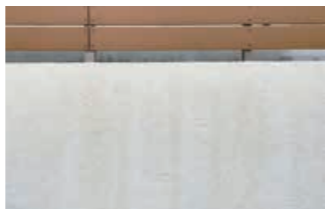
㉔ 塗装仕上げの壁(白)
