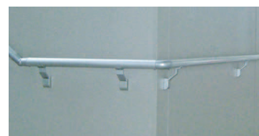
補助手すり/丸パイプ
